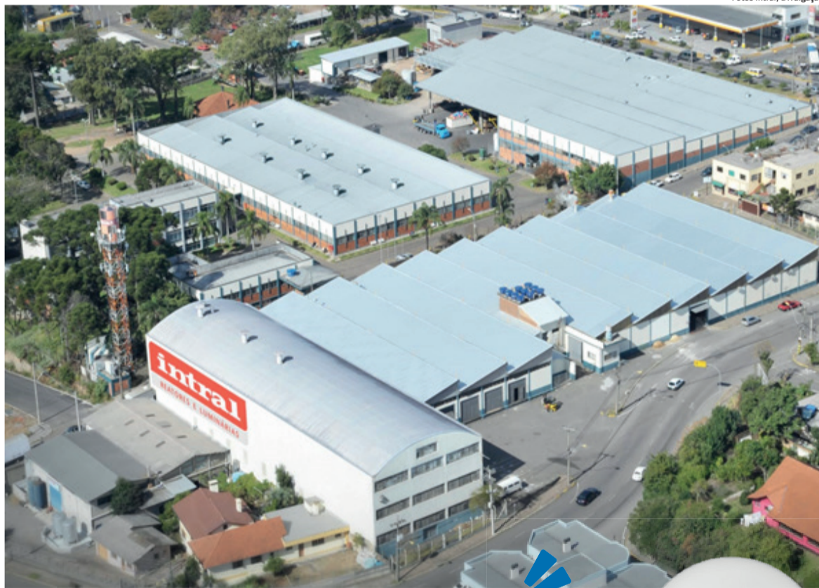
FÁBRICA CONTA COM LABORATÓRIOS PRÓPRIOS PARA TESTES DOS PRODUTOS
